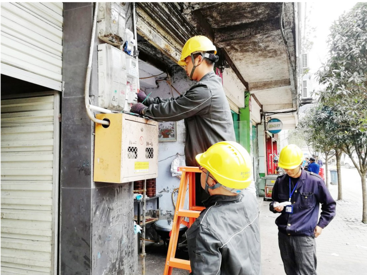
工作人员安装第三级漏电保护装置。
