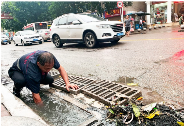
► 工作人员疏通积水路面。 ▼ 工作人员清理下水道口。
