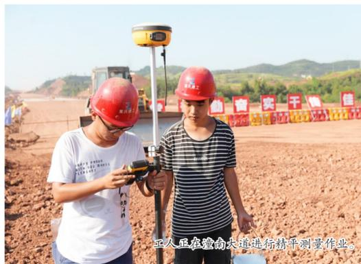
工人正在潼南大道进行精平测量作业。
