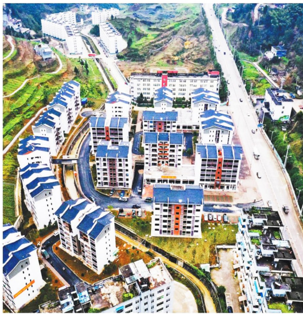
黔江区李家溪安置点。
