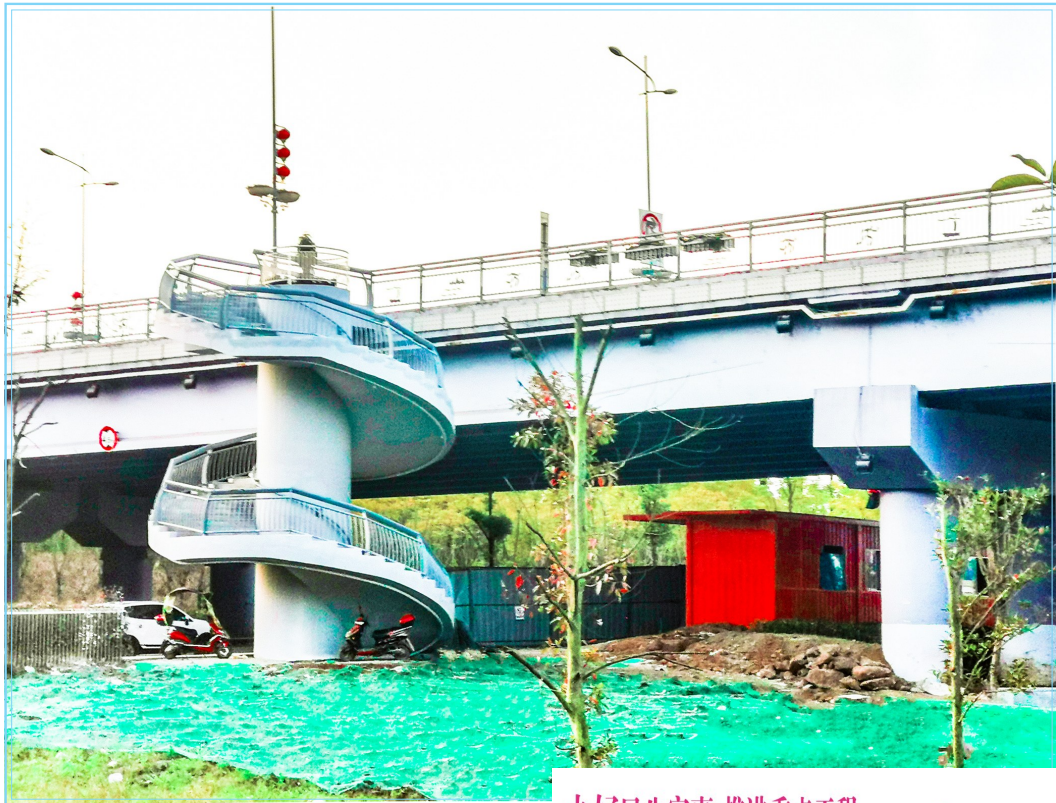
螺旋楼梯建成投用。
