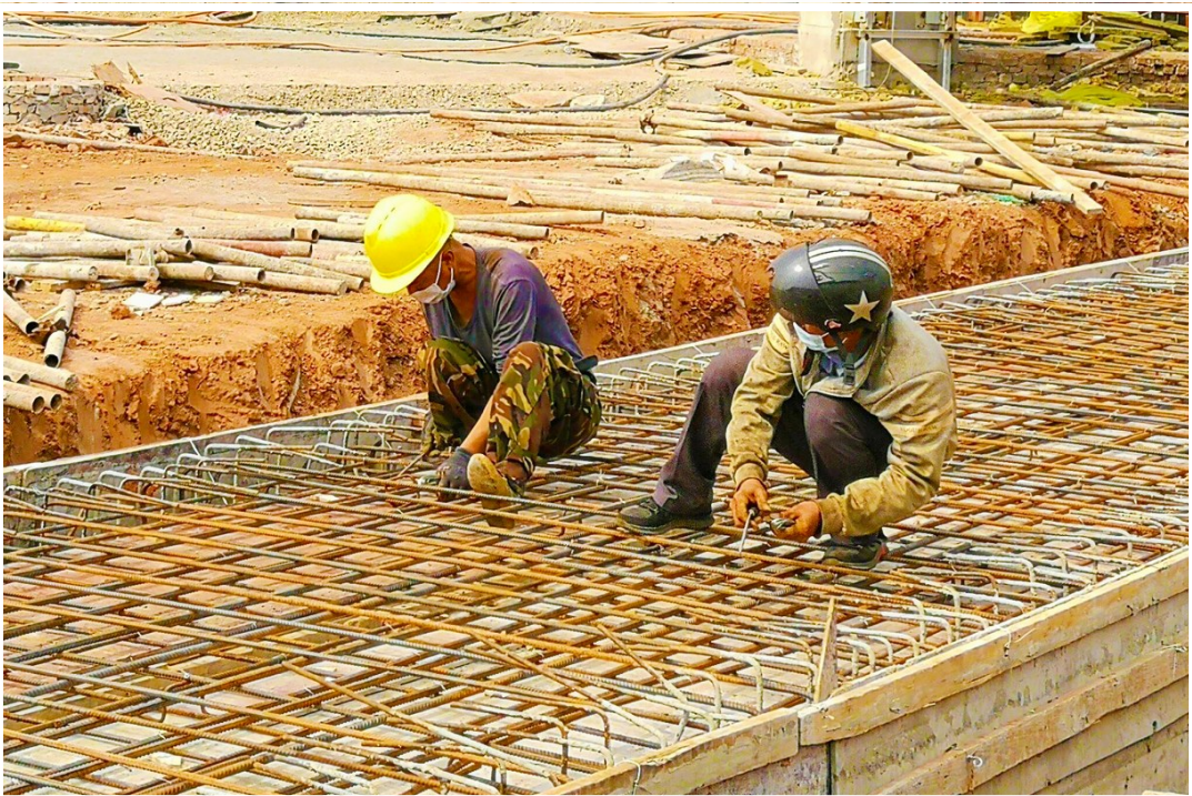
工人们正在绑扎电缆沟顶板钢筋。
