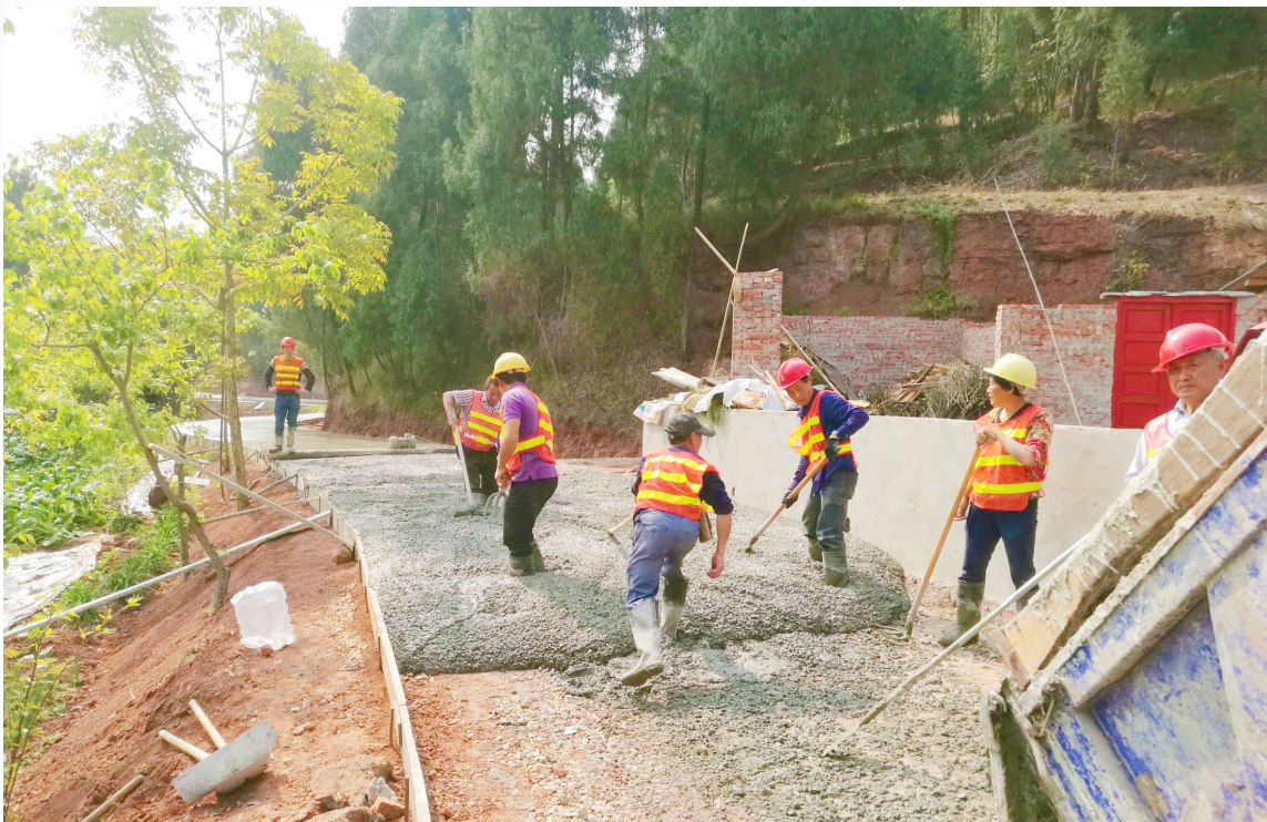
花岩镇“四好农村公路”施工现场。
