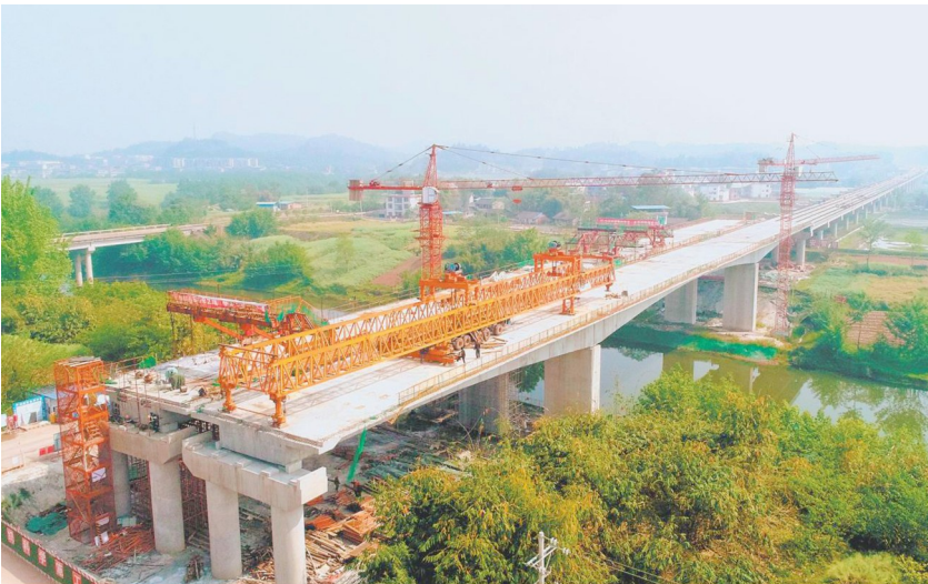
4月13日，重庆合川至四川安岳高速公路(重庆段)控制性工程——崇龛琼江大桥主跨顺利合龙。 重庆日报记者 罗斌 摄
