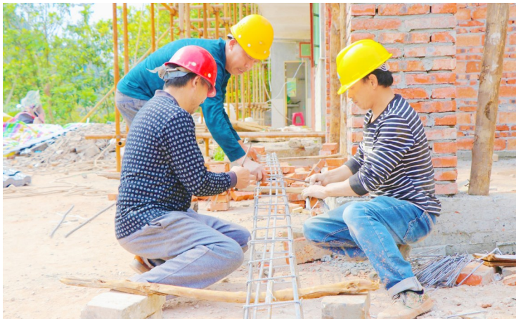
► 5月13日，在双江G26沿线，农民工正在绑扎钢筋，改造提升公共服务设施。
