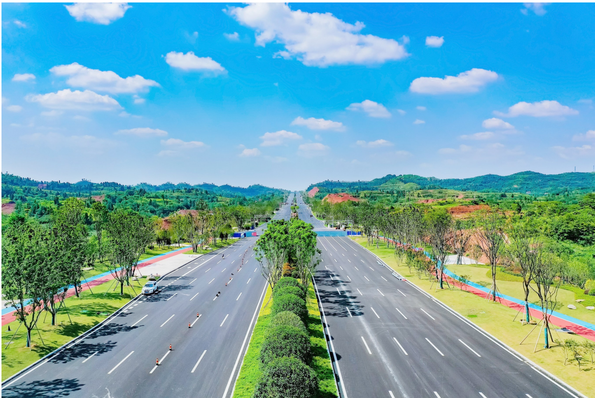
已竣工的潼南大道。
