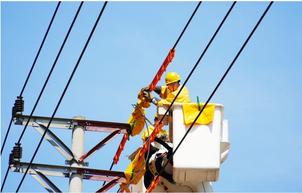
▲ 电力工人在整理带电作业设备。 ▶ 电力工人在进行带电作业。
