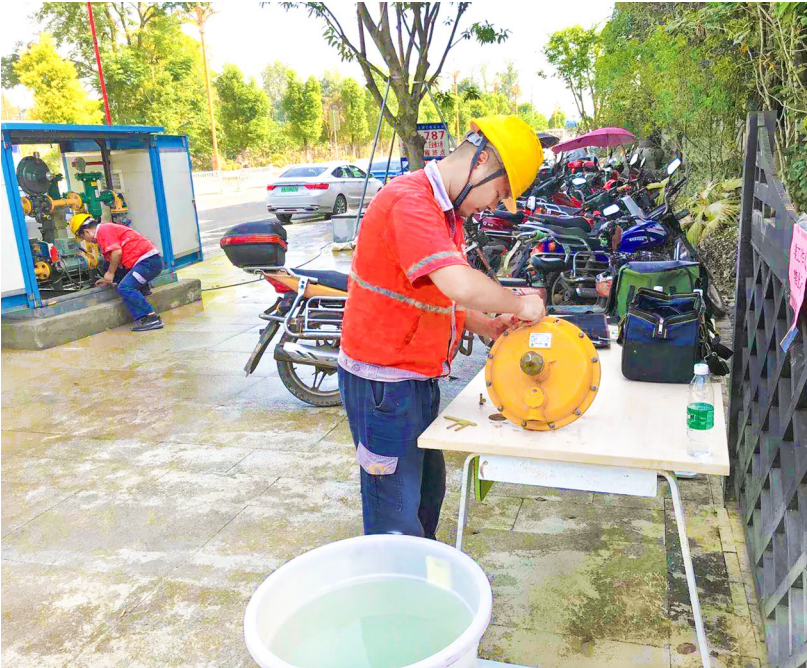
上图:检修气表。 右图:维修燃气设施设备。
