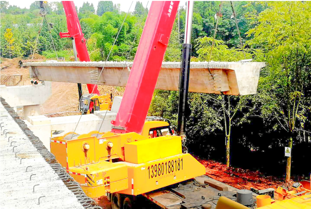
双江航电枢纽辅助道路桥梁吊装T型梁 全媒体记者 陈晓航 摄
