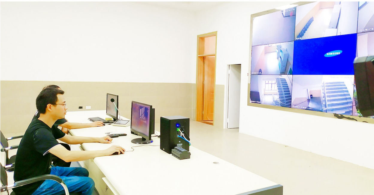
潼南人民小学校园视频监控系统。
