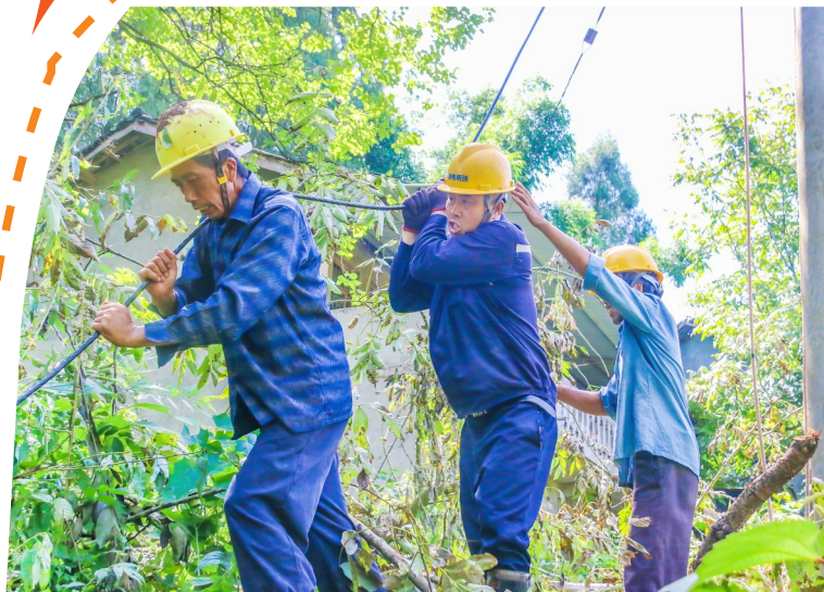
电力工人在施放导线。
