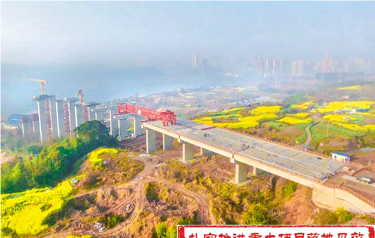
东升大桥引桥铺设T梁。
