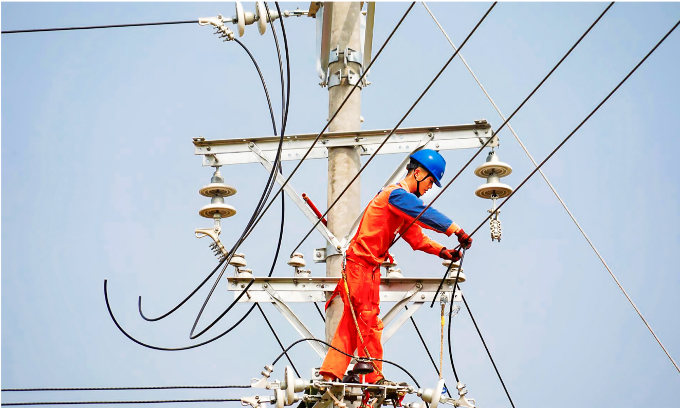
工人凌空拉结电缆作业。
