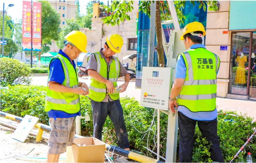
工作人员在安装化粪池安全监控智能处置设备。
