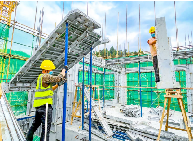
工人正在安装铝合金模板。
