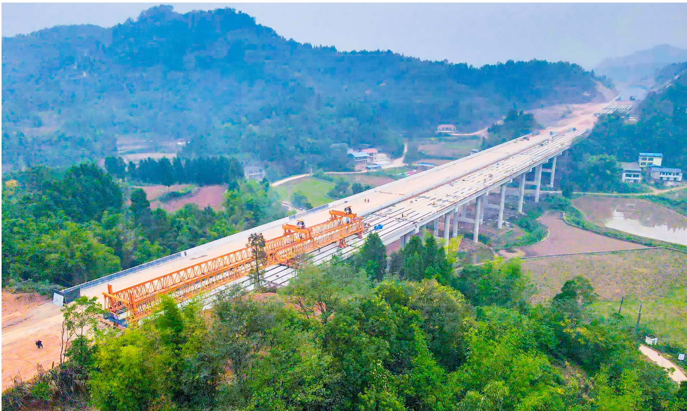
铜安高速(潼南段)卧佛镇香炉村大桥施工现场。
