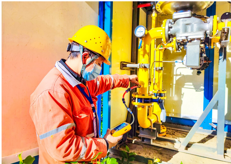
燃气工人对调压柜进行压力测试。
