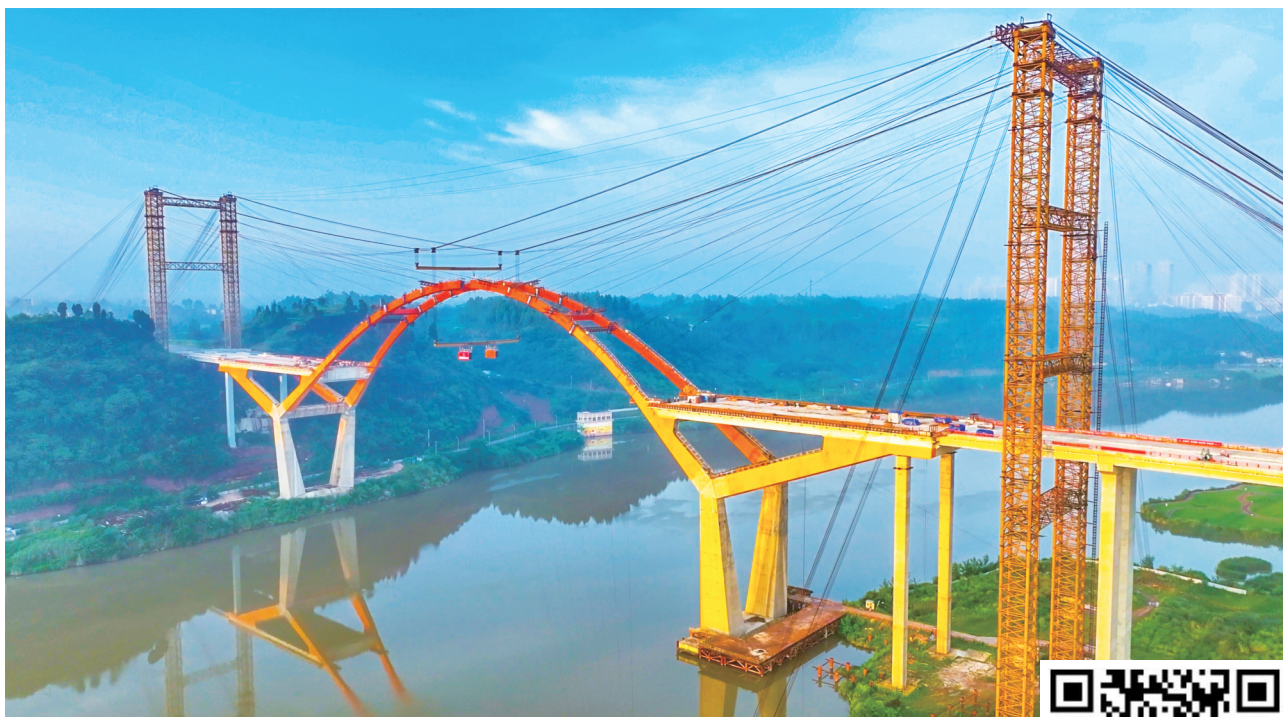
东升大桥钢结构主拱合龙进行中。
