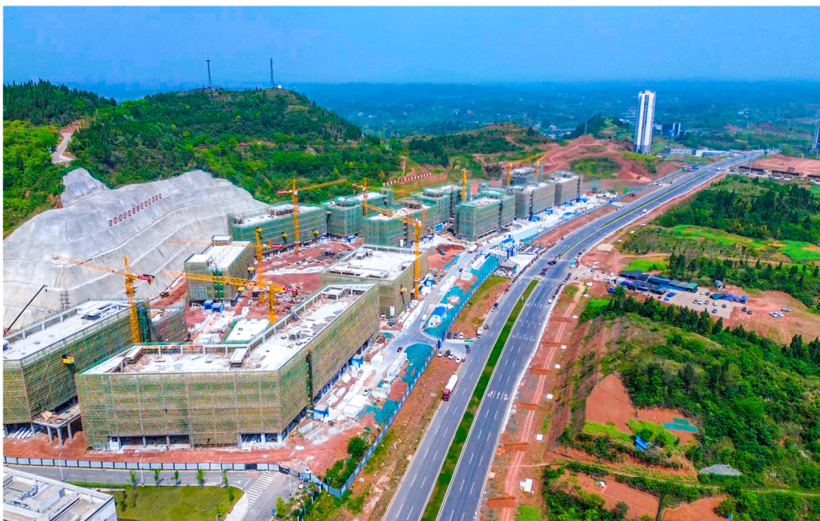
重庆电力高专(潼南校区)二三期工程建设现场。
