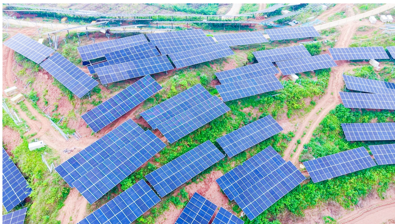
项目现场，光伏桩基整齐排布绵延铺展。
