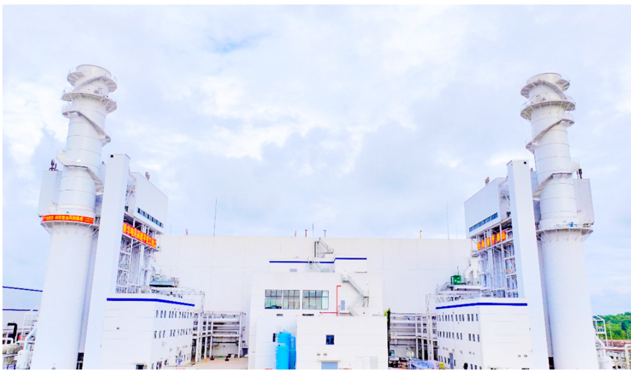
华电燃机项目主厂房。
