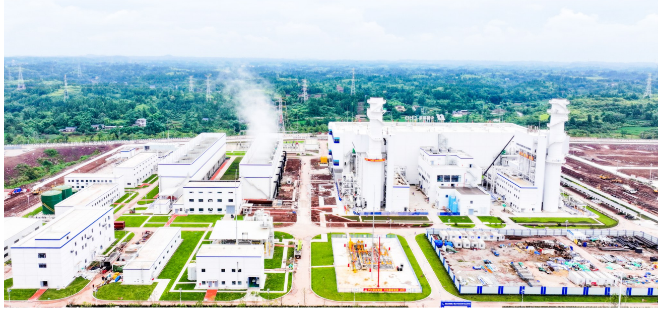
航拍华电潼南天然气发电项目全景。
