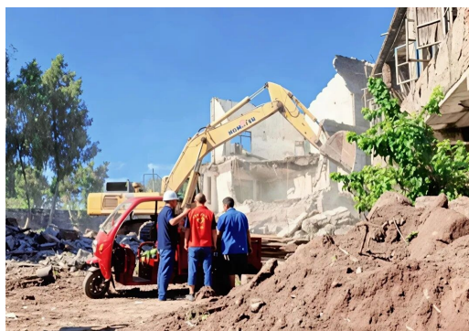
古溪镇开展危房排危专项行动。
